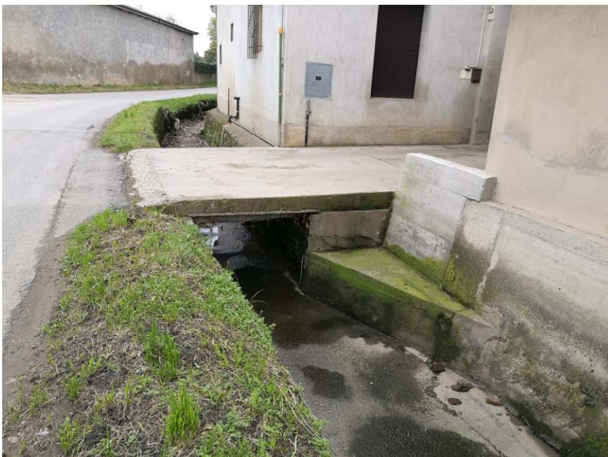
CANALE MOTTA GROSSA - ACCESSI ABITAZIONI
