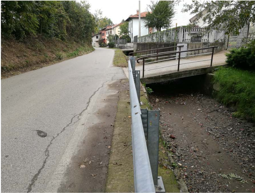
CANALE MOTTA GROSSA - ACCESSI ABITAZIONI
