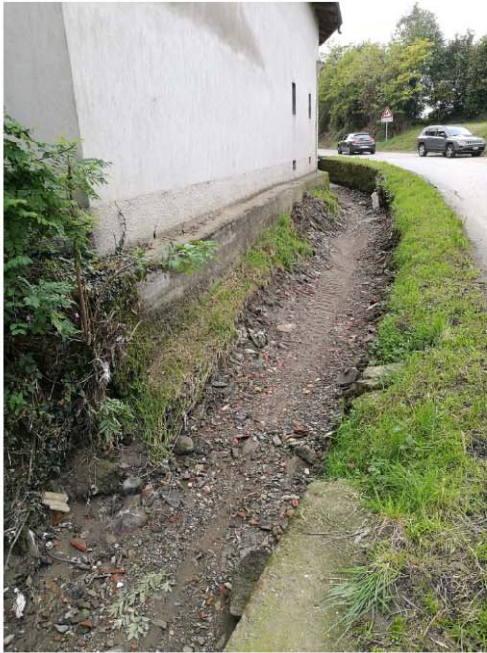
CANALE MOTTA GROSSA
