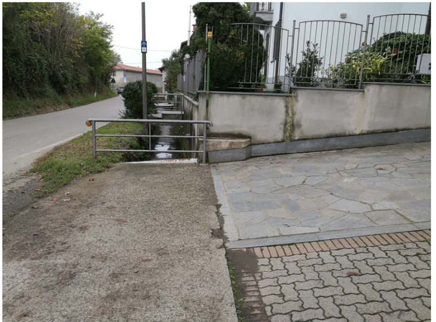
CANALE MOTTA GROSSA - ACCESSI ABITAZIONI
