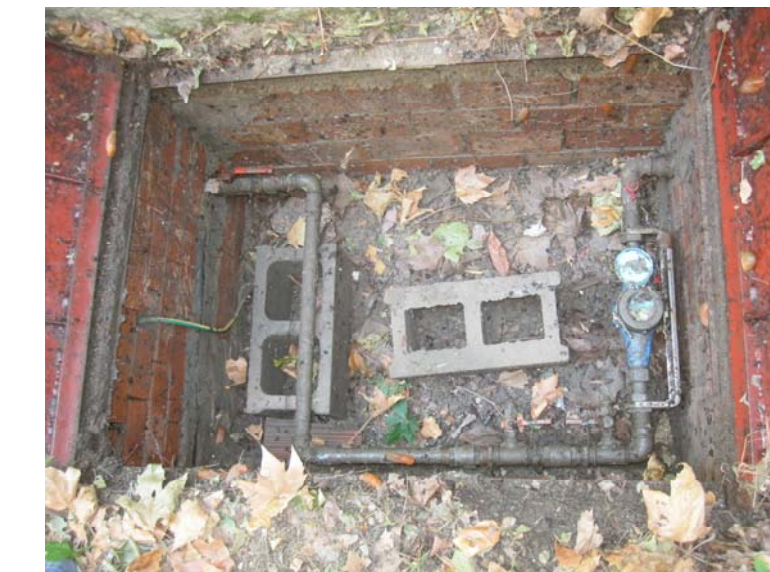
FOTOGRAFIA N.5: POZZETTO DI ALLACCIAMENTO ALLA RETE IDRICA ESISTENTE
