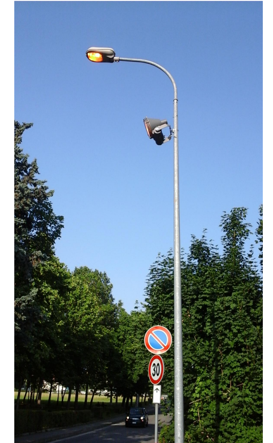
Palo stradale con proiettore che illumina parco situato in Via Nino Costa
