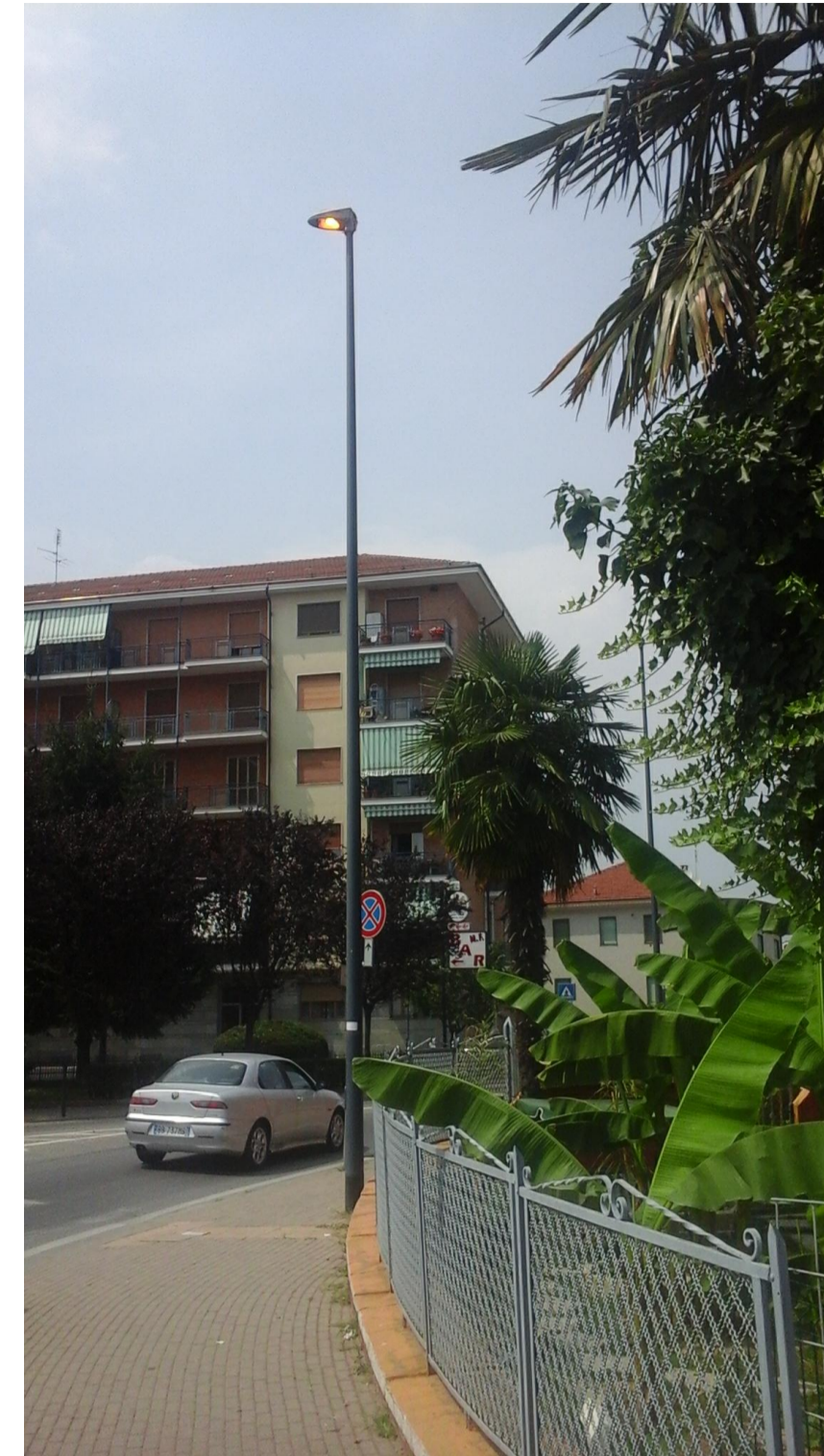
Palo stradale situato in Via Susa
