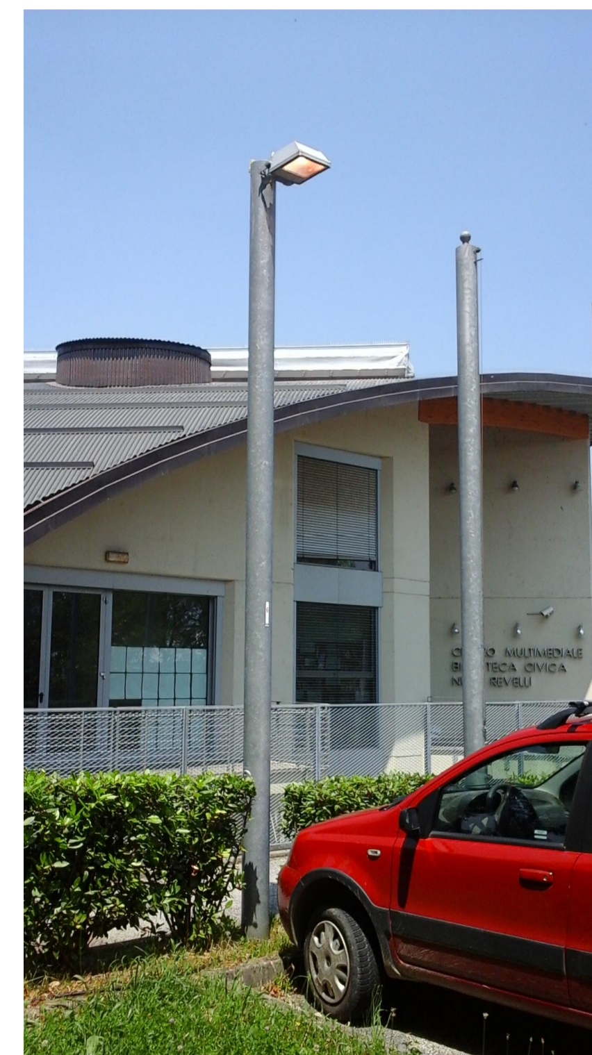
Palo con proiettore sito nel posteggio della biblioteca civica
