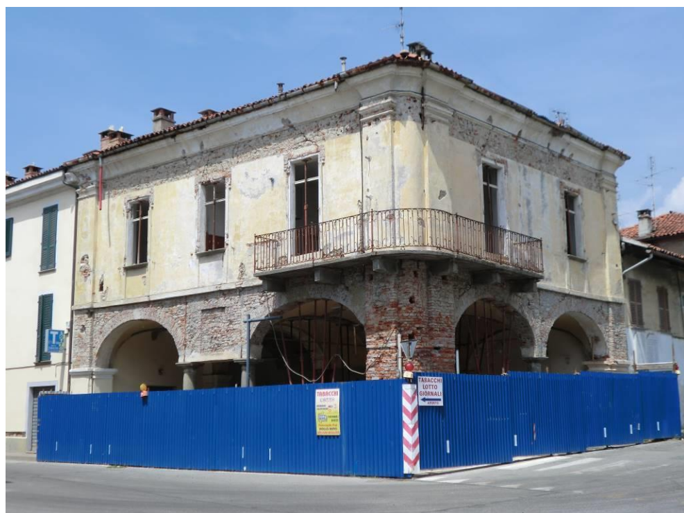
Vista dell'edificio da via Nazionale – Situazione attuale
