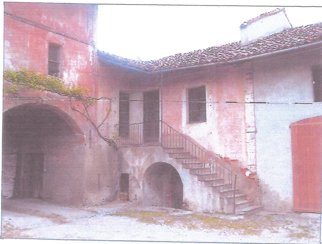
VISTA DAL CORTILE IN PROSSIMITA' DELL' ANDRONE DI INGRESSO: LA SCALA ESTERNA APERTA CON IL SOTTOSCALA IN MURATURA
