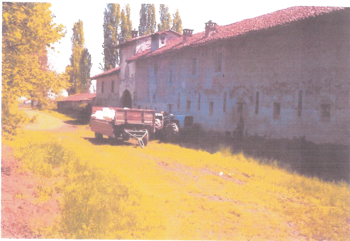
VISTA DELLA "MANICA NORD" DALL'ESTERNO
