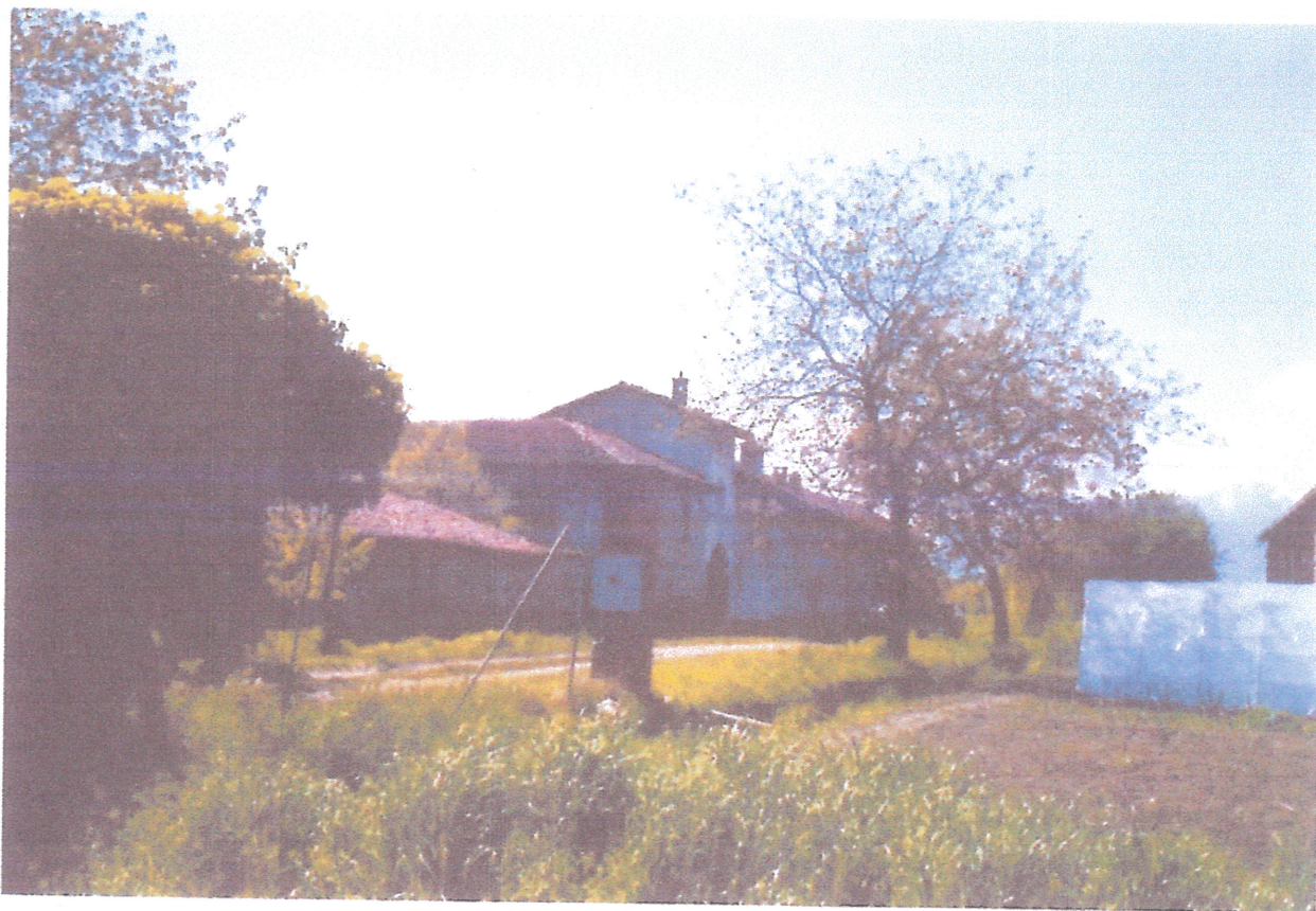
SCORCIO DELLA "CASCINA" IN PROSSIMITA' DELLA STRADINA DI ACCESSO ALL'AREA
