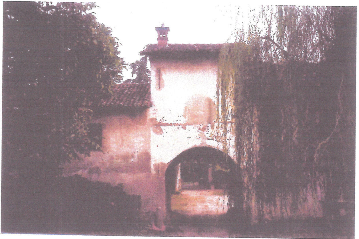
VISTA DALL'ESTERNO: IL TORRINO E L'ANDRONE DI INGRESSO
