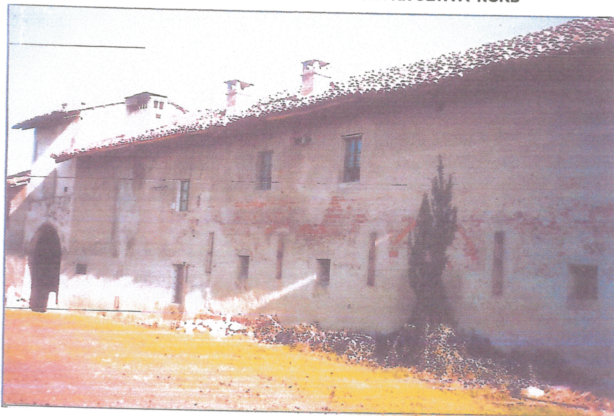
VISTA DALL'ESTERNO: FACCIATA RIVOLTA A NORD
