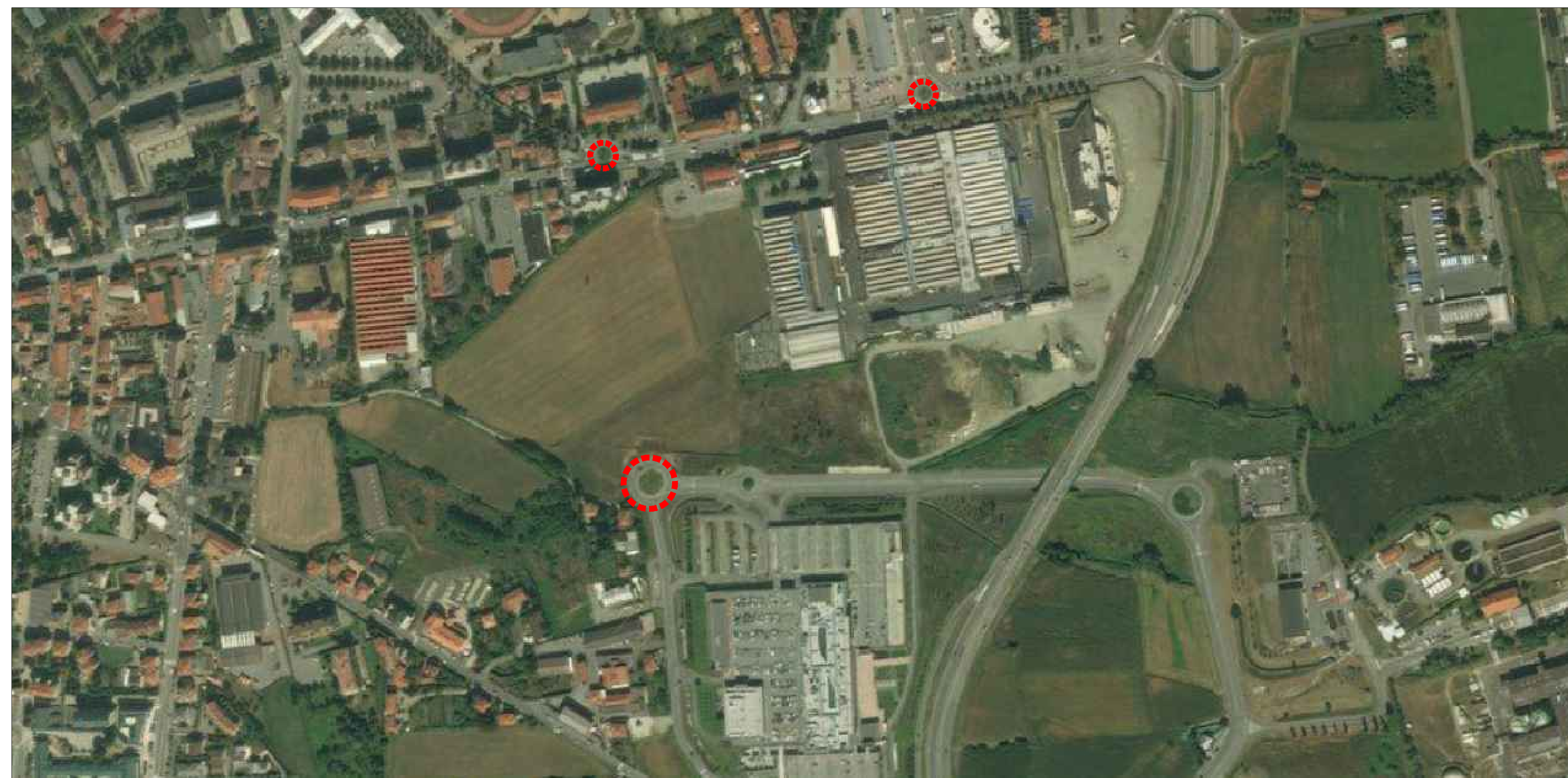
COMUNE DI PINEROLO - Area di interesse - FOTO AEREA (maggio 2018) con individuazione delle rotonde esistenti a margine dell'area
