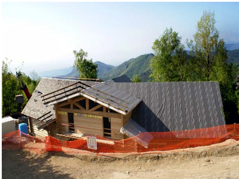
Casa Canada in fase di montaggio
