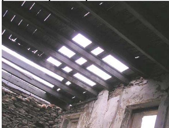
Attuale stato della copertura
