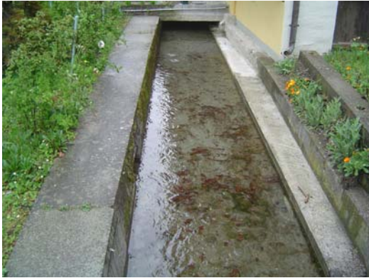
Il canale esistente
