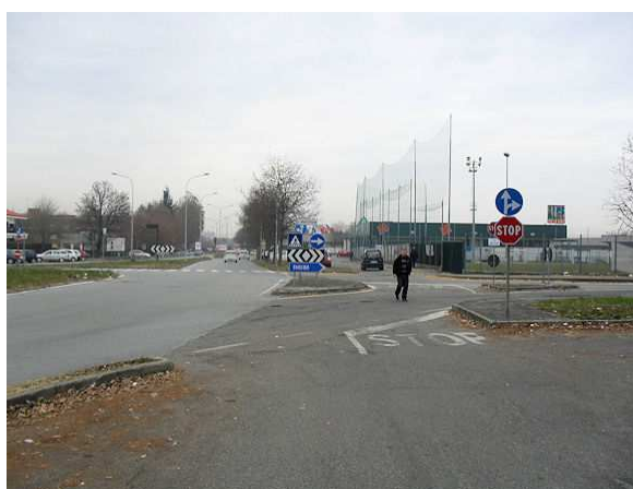
Uscita esistente dal controviale sud-ovest
