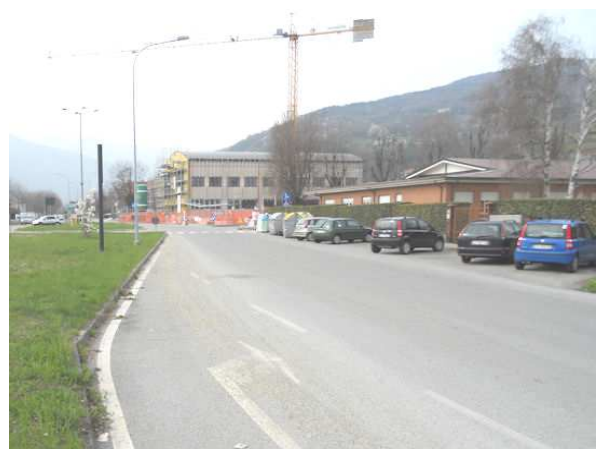
Corsie e parcheggio sul lato nord-est
