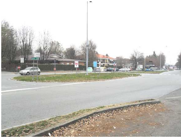
Vista generale da sud-ovest
