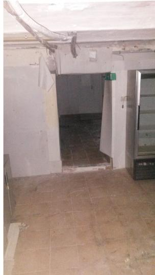
Prima di una accurata pulizia del locale piano interrato si dovrà provvedere alla rimozione dalle murature di staffe, mensole e altre parti metalliche non più utilizzate, avendo cura di eliminare gli elementi sporgenti della muratura.
