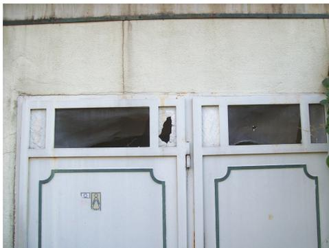
Dovranno essere posate internamente al serramento delle nuove griglie in acciaio verniciato sopra le due porte del servizio igienico esistente in corrispondenza dei fori principali (si veda immagine dei serramenti).
