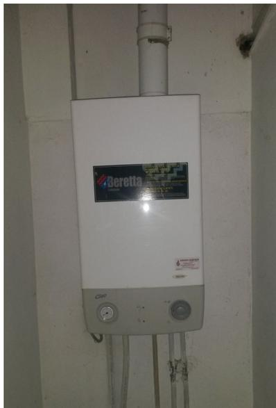
L'impianto termico attuale è costituito da un generatore di acqua calda murale a gas metano e da una rete di termoconvettori dislocati nei diversi spazi della struttura.
