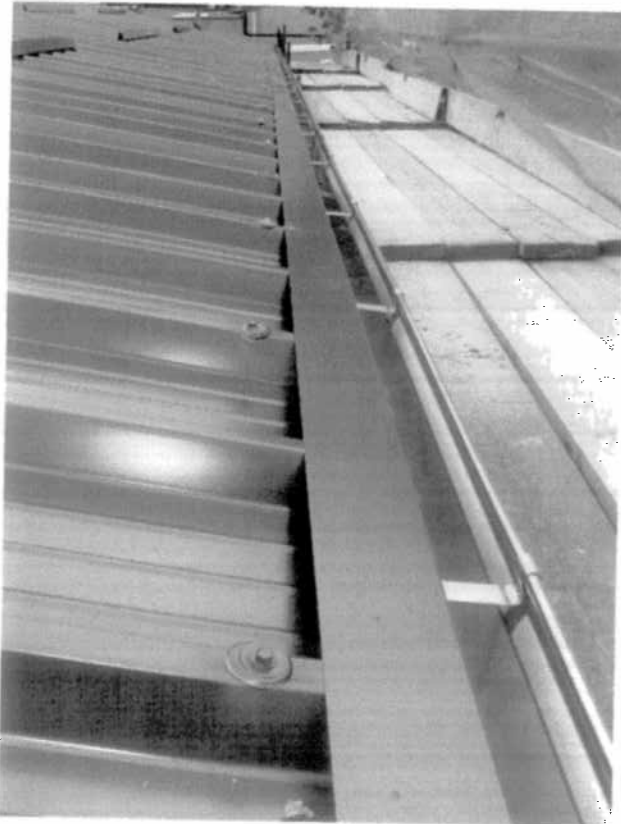
PARTICOLARE TIPO ROMPIGETTO GRONDA
