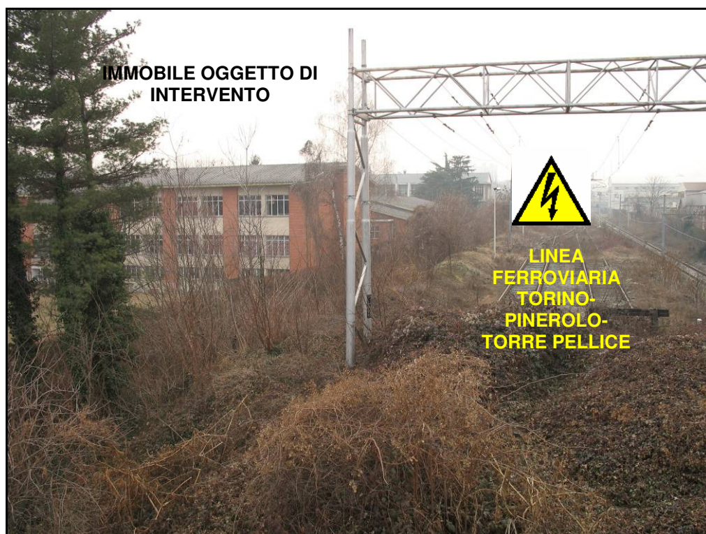
RIPRESA N. 4 – vista fronti est e nord (verso ferrovia)
