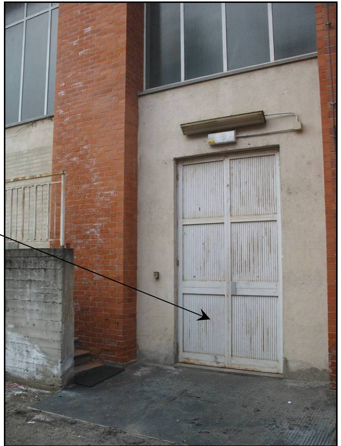
RIPRESA N. 11 – uscita sicurezza palestra verso cortile interno
