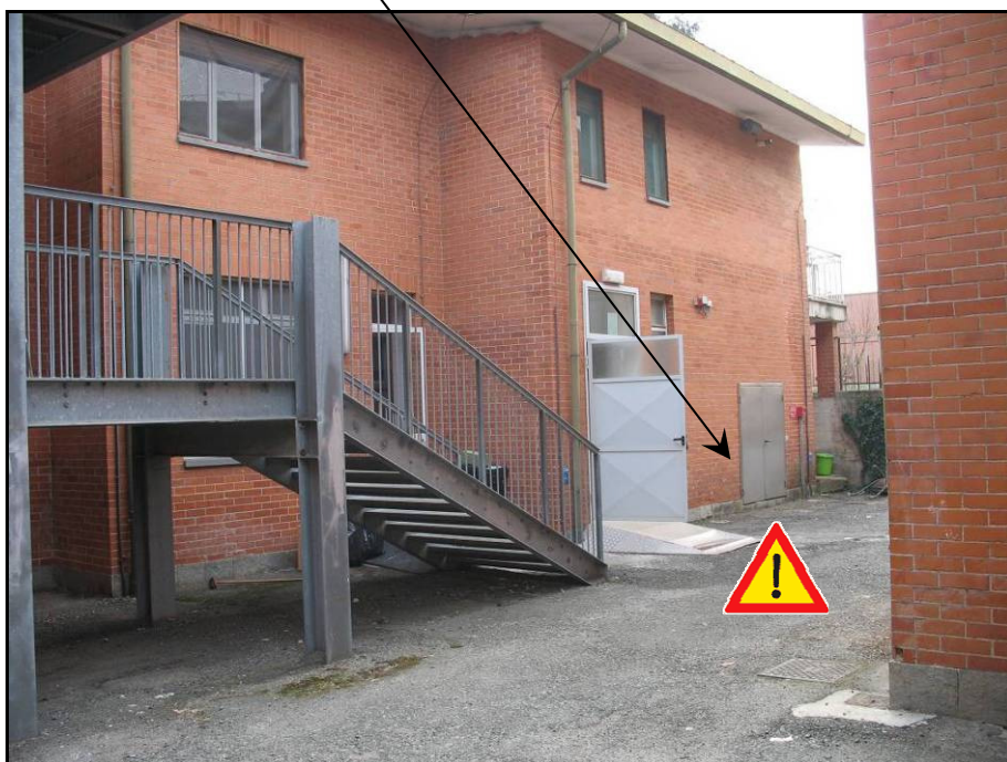
RIPRESA N. 16 – partenza scala emergenza verso cortile interno
