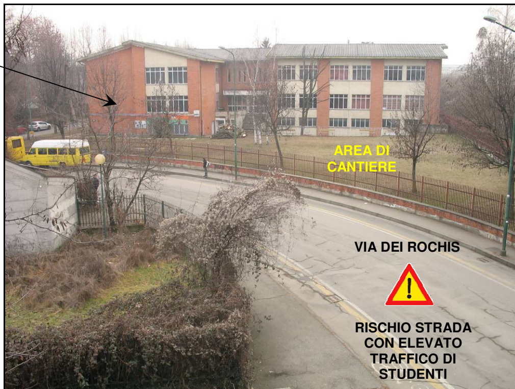
RIPRESA N. 1 – area cantiere e fabbricato verso via Dei Rochis
