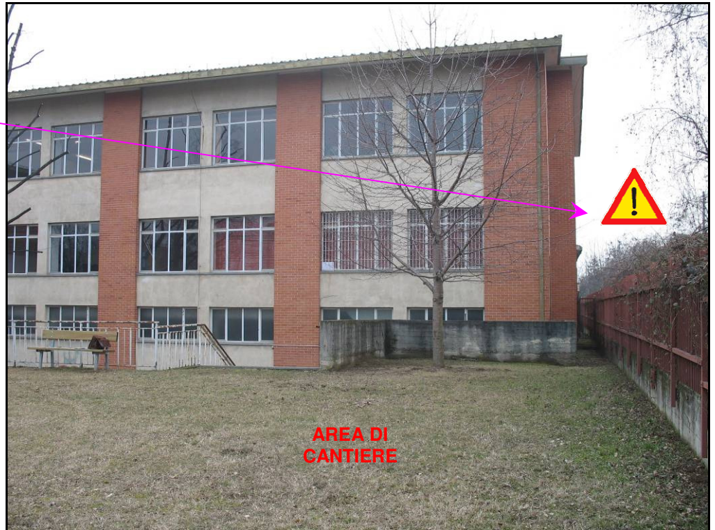
RIPRESA N. 23 – fronti e recinzioni verso ferrovia
