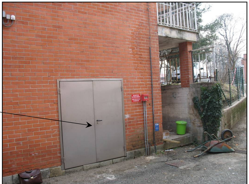
RIPRESA N. 12 – porta centrale termica verso cortile interno
