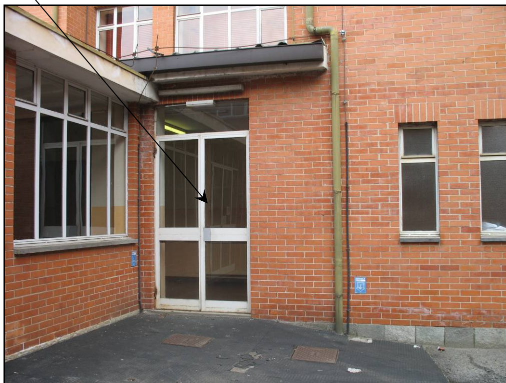
RIPRESA N. 14 – uscita sicurezza verso cortile interno
