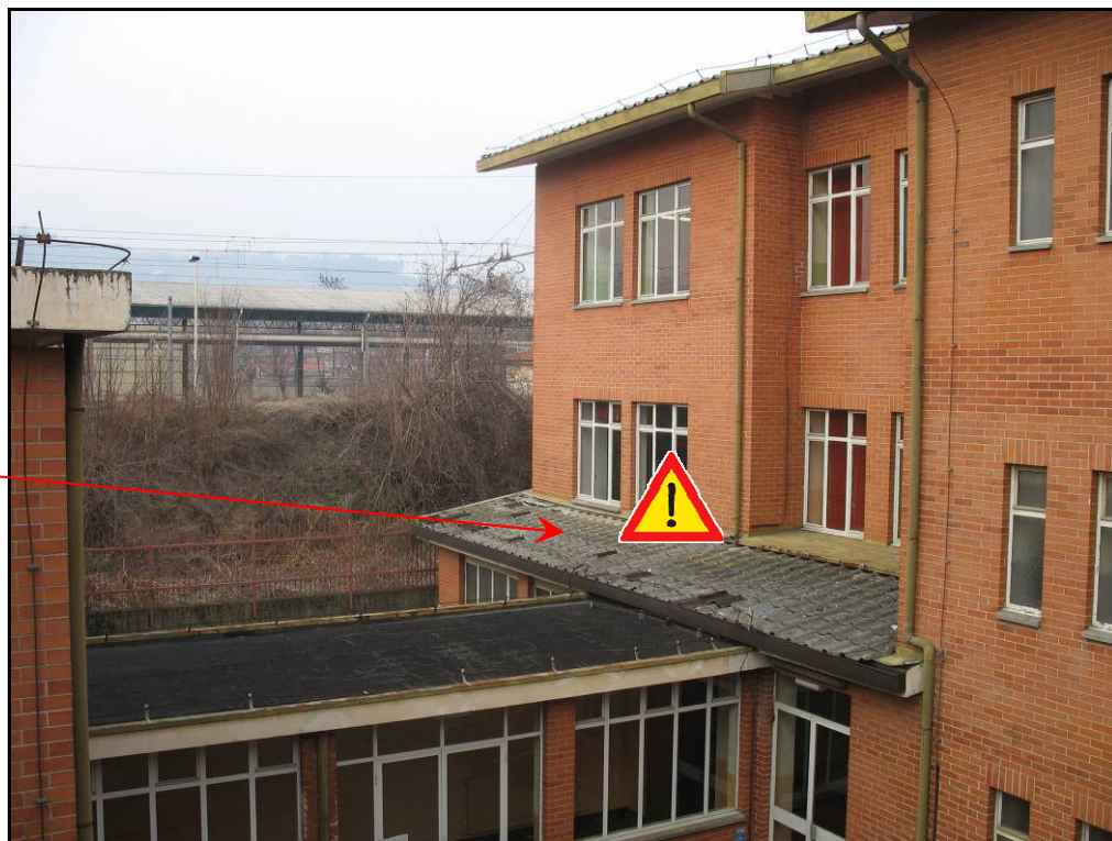
RIPRESA N. 21 – tetto basso verso ferrovia
